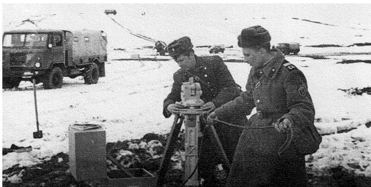
Определение азимута на гиротедолите Ги-Б2. Расчёт Князева Н.
