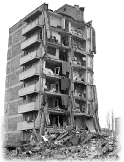
Один из разрушенных домов
